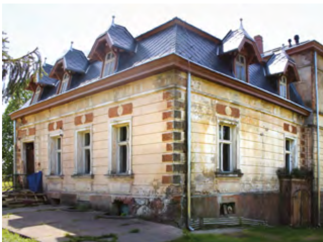
Remont dachu zabytkowego dworu w Mniszkach
