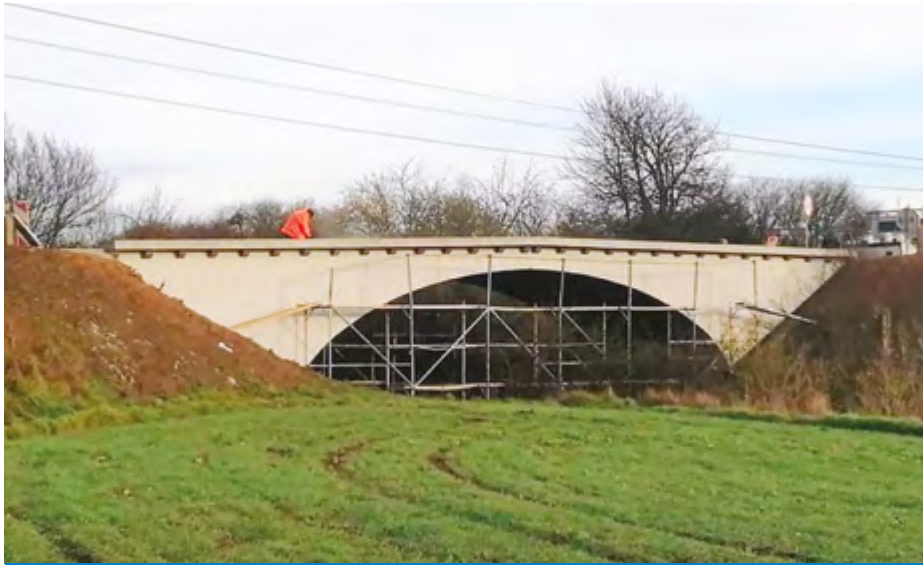
Remont wiaduktu nad linią kolejową w Głazewie
