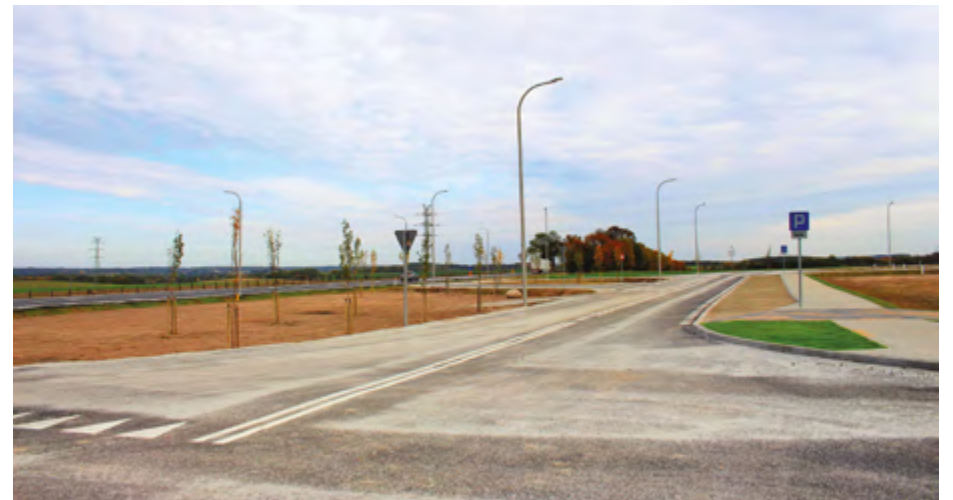
Budowa dróg dojazdowych do terenów inwestycyjnych w Gorzynie
