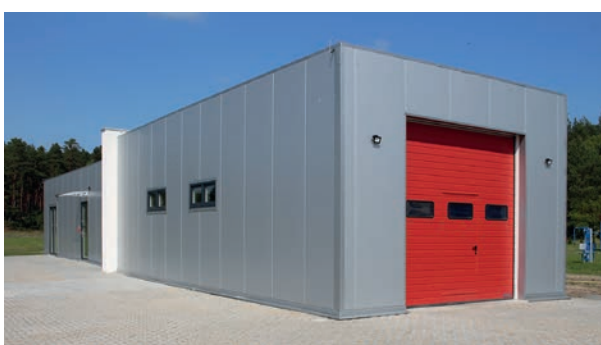
Budowa remizy OSP ze świetlicą wiejską w Piłce, dofinansowana ze środków Rządowego Funduszu Inwestycji Lokalnych
