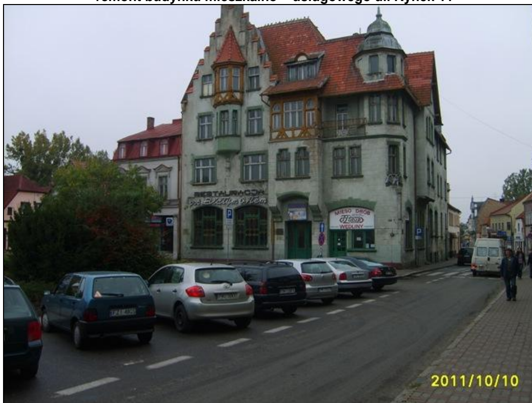
Zdjęcie 48. Rewitalizacja centralnej części Starego Miasta – płyta rynkowa wraz z otoczeniem: - remont budynku mieszkalno – usługowego ul. Rynek 11
