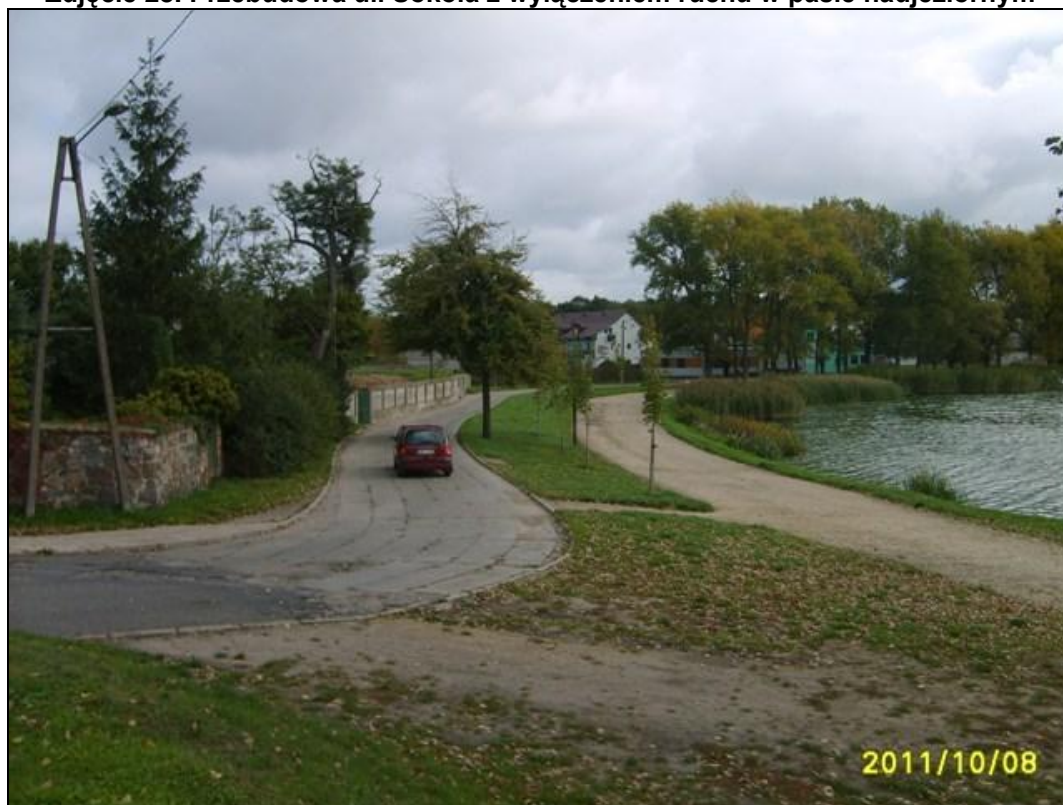
Zdjęcie 28. Przebudowa ul. Sokoła z wyłączeniem ruchu w pasie nadjeziornym
