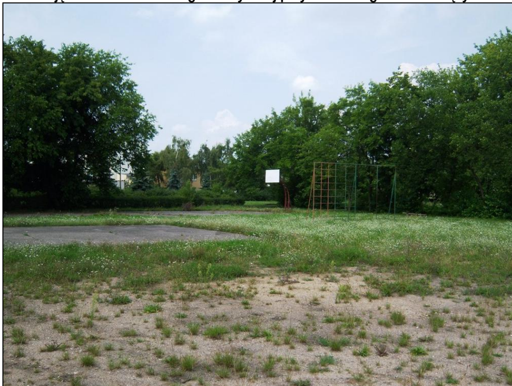
Zdjęcie 41. Budowa sali gimnastycznej przy Liceum Ogólnokształcącym
