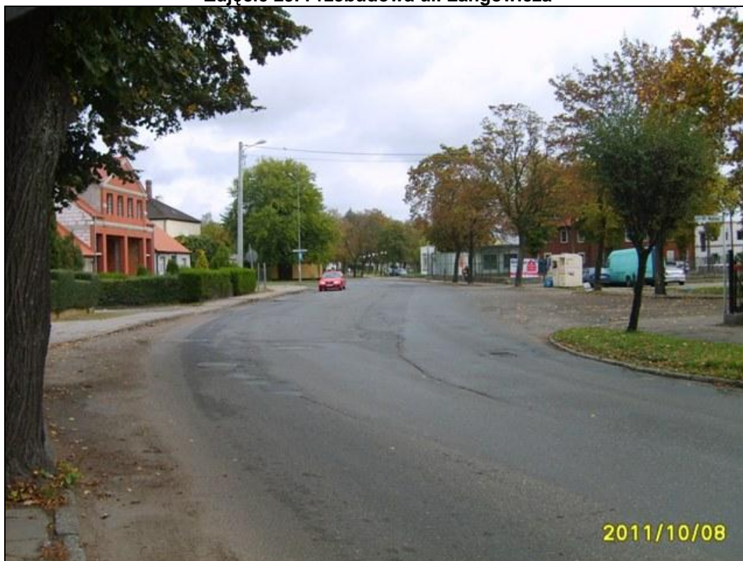
Zdjęcie 29. Przebudowa ul. Langowicza
