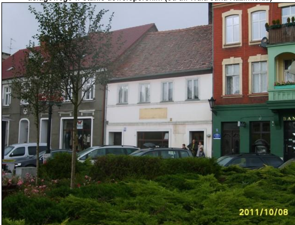
Zdjęcie 24. Budowa budynku mieszkalno – usługowego (ul. 17 Stycznia 53) oraz budynku usługowego w stanie deweloperskim (od ul. Wała Jana Kazimierza)
