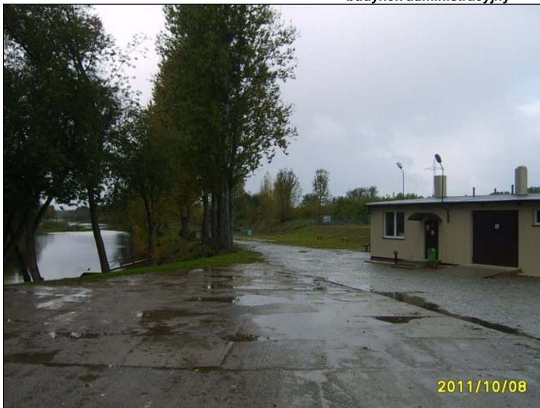
Zdjęcie 39. Rozwój infrastruktury turystyczno – rekreacyjnej na terenie Starego Portu – Budowa obiektów kubaturowych: hangary, budynek administracyjny
