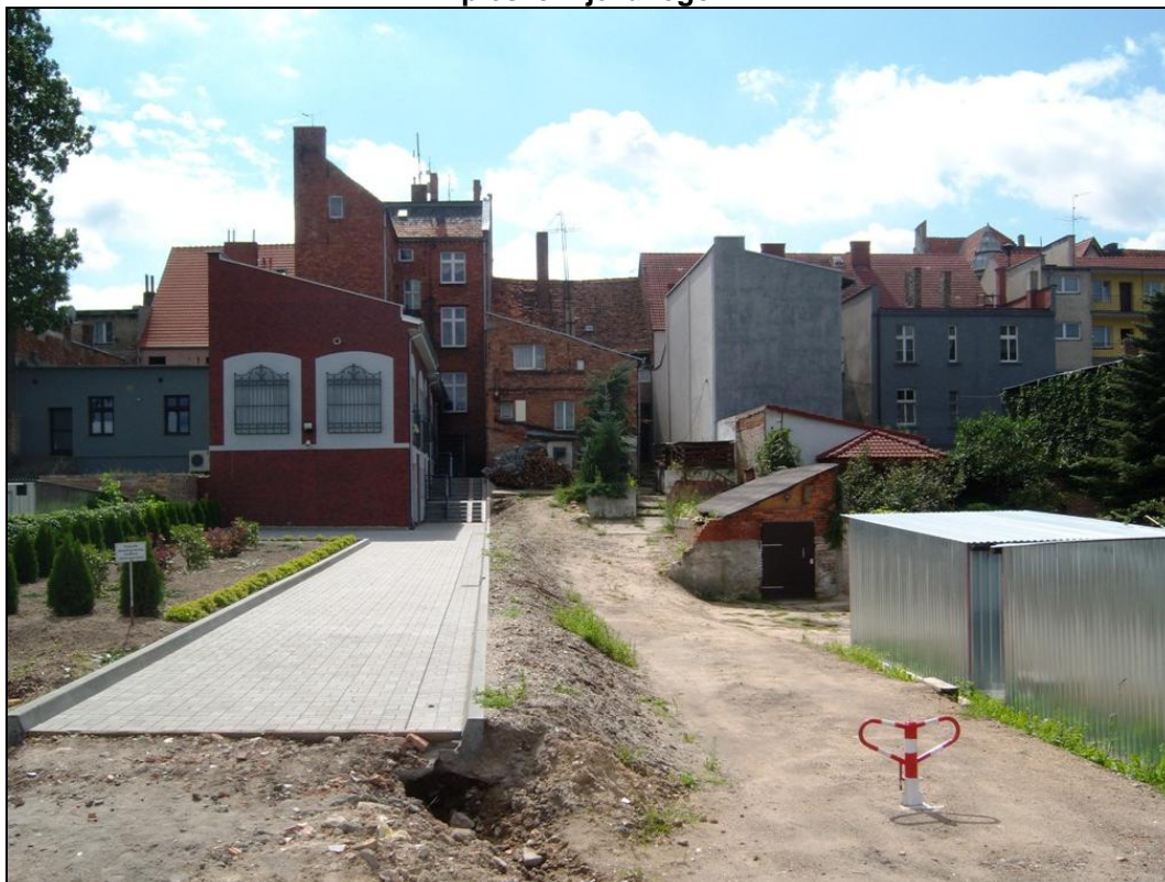
Zdjęcie 25. Pasaż handlowy z windą i budynkiem usług turystycznych oraz nawierzchnie ciągu pieszo – jezdnego
