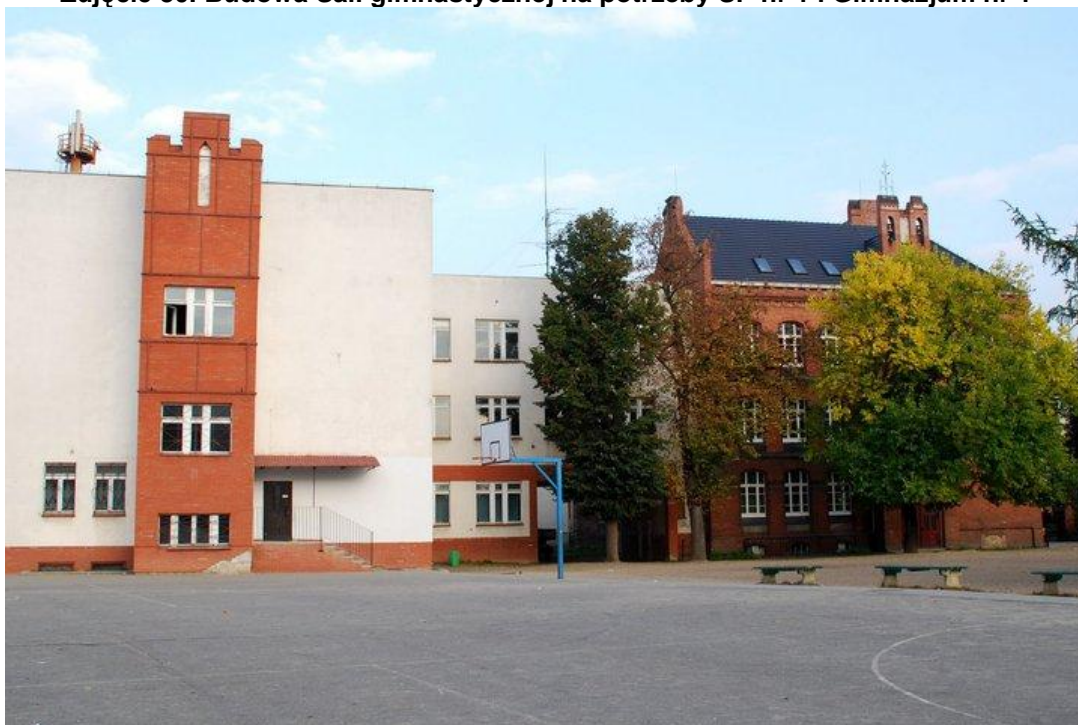
Zdjęcie 30. Budowa Sali gimnastycznej na potrzeby SP nr 1 i Gimnazjum nr 1
