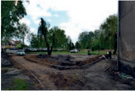
Montaż krawężników – ul. 17 Stycznia (fot. A. Barszczewska)
