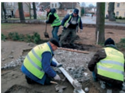
Naprawa nawierzchni z kostki brukowej (fot. A. Barszczewska)
