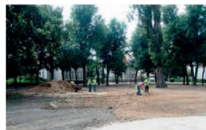
Widok Parku im. Michała Skrzypczaka - plantowanie terenu (fot. N. Jandy)
