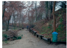
Oczyszczanie skarpy – strefa nadjeziorna (fot. A. Barszczewska)
