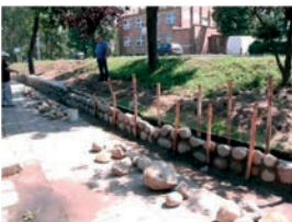
Budowa murku oporowego z kamieni polnych (fot. N. Jandy)
