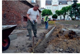
Członkowie KIS-u podczas montażu krawężników (fot. A. Barszczewska)
