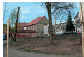
Widok na skarpe po usunięciu drzew i murawy (fot. A. Barszczewska)
