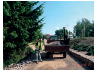
Utwardzanie nawierzchni (fot. A. Barszczewska)
