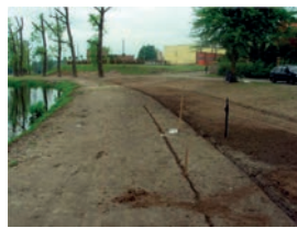
Wyznaczanie i profilowanie ciągów pieszych (fot. N. Jandy)
