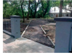
Wyznaczenie ciągów komunikacyjnych – skwer przy ul. Sikorskiego (fot. N. Jandy)
