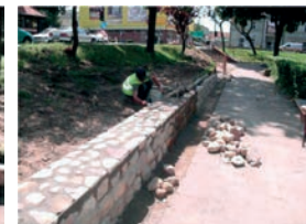
Murek oporowy (fot. N. Jandy)
