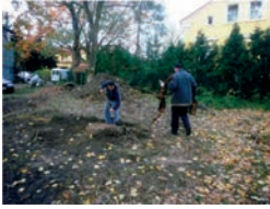
Oczyszczenie terenu – skwer przy ul. Sikorskiego (fot. N. Jandy)
