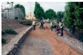
Utwardzanie nawierzchni pieszej (fot. A. Barszczewska)
