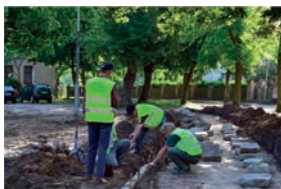
Montaż krawężników granitowych w Parku im. Michała Skrzypczaka (fot. A. Barszczewska)
