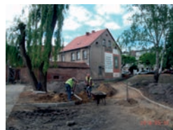
Montaż krawężników – ul. 17 Stycznia (fot. A. Barszczewska)
