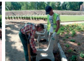
Montaż fawek w Parku za Pomnikiem Harcerzy (fot. A. Barszczewska)
