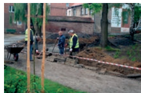
Montaż krawężników – ul. 17 Stycznia (fot. A. Barszczewska)
