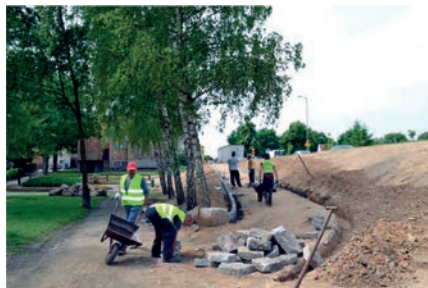
Profilowanie skarpi i montaż krawężników przy ul. Czynu 600-lecia (fot. A. Barszczewska)
