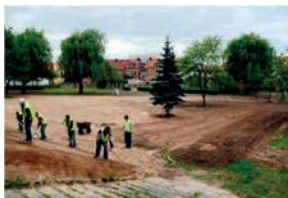
Prace rewitalizacyjne – plantowanie terenu (fot. N. Jandy)
