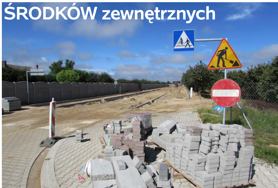
Trwają prace przy budowie ul. Zagrodowej
