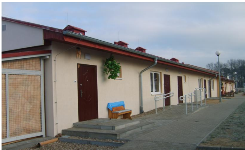
Zdjęcie 41 Budowa budynku socjalnego w Kolnie Źródło: [UM i G Międzychód]
