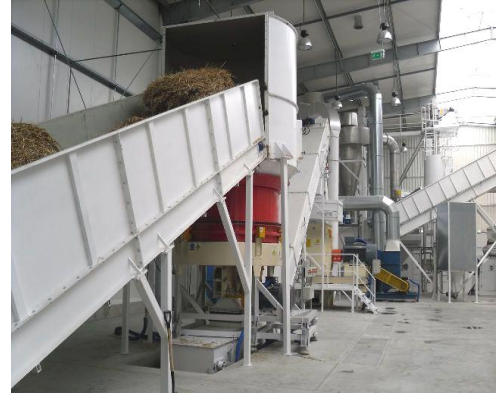
Zakład Green Energia w Łowiniu
